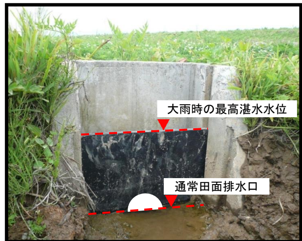
水位調整板の設置状況
