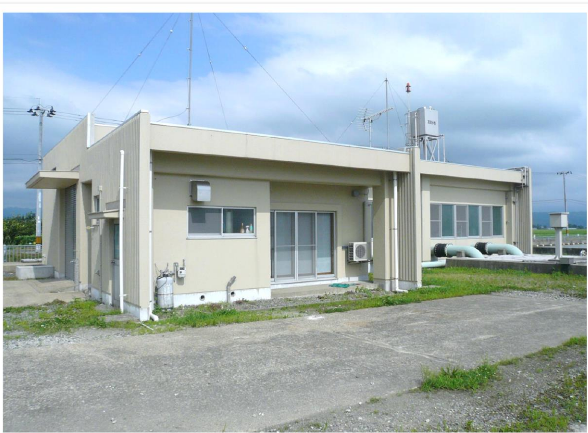
平成25年度 基幹水利施設ストックマネジメント事業建屋補修工事（八栄島第二揚水機場）
